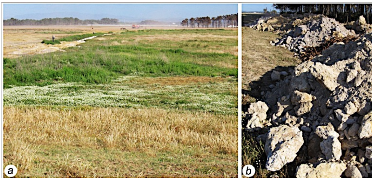
Figura 6. Em a) plano húmido com vegetação herbácea verde e hidratada contrastando com a vegetação de solos secos adjacentes em tons amarelados. Observa-se uma vala do lado esquerdo que eficazmente capta os fluxos sub-superficiais. Em b) acumulação de blocos de um imperme desenterrado por maquinaria para favorecer a percolação nos locais de cultivo. Imagens obtidas a 4 de Junho de 2017, a norte da povoação de Odeceixe, num local fora da área de estudo do presente trabalho, na área beneficiada pela irrigação do AHM.
